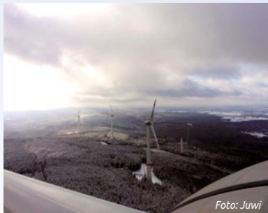
Windpark Ellern, Sicht von Gondel
