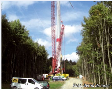
Bauphase der Windenergieanlage
