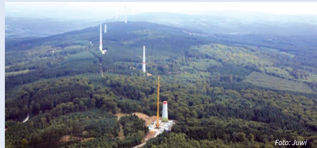
Windpark Ellern in Bau
