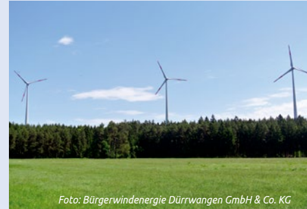
Seitenansicht Bürgerwindpark Dürrwangen
