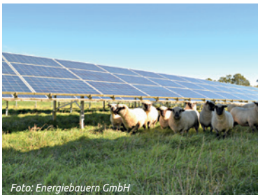
Foto: Energiebauern GmbH
