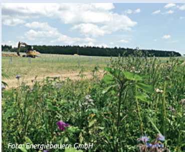
Foto: Energiebauern GmbH
